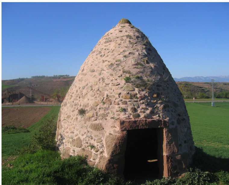
Chozo rehabilitado. Badarán. La Rioja. España.
